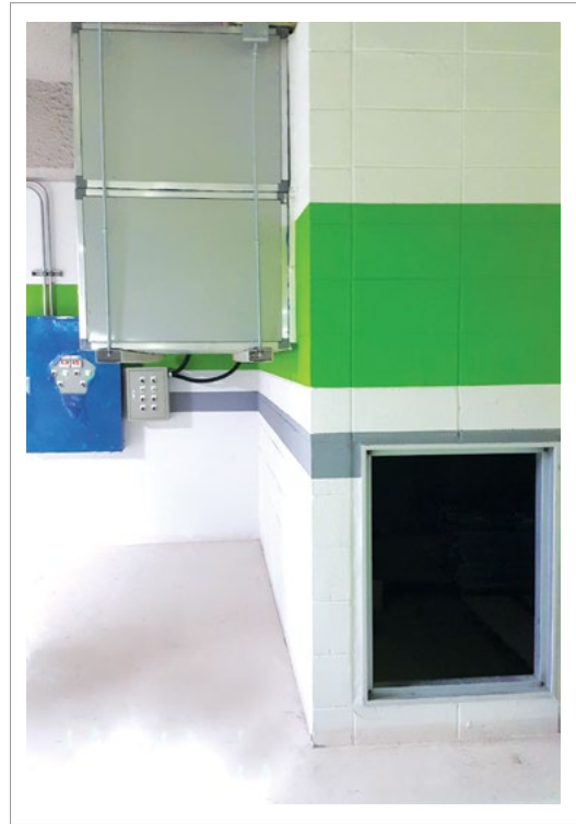
패시브 배기팬 설치 사진
